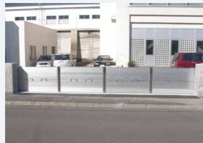
防水扉(終末処理場)
