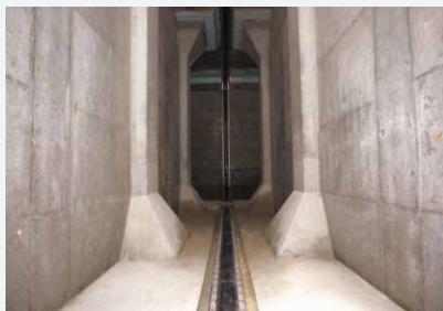
上水道用後付式ゴム伸縮可撓継手
