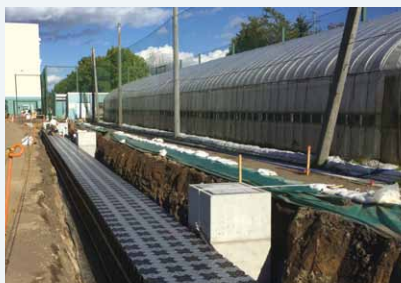
雨水貯留施設
