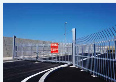
侵入防止用フェンス・門扉
