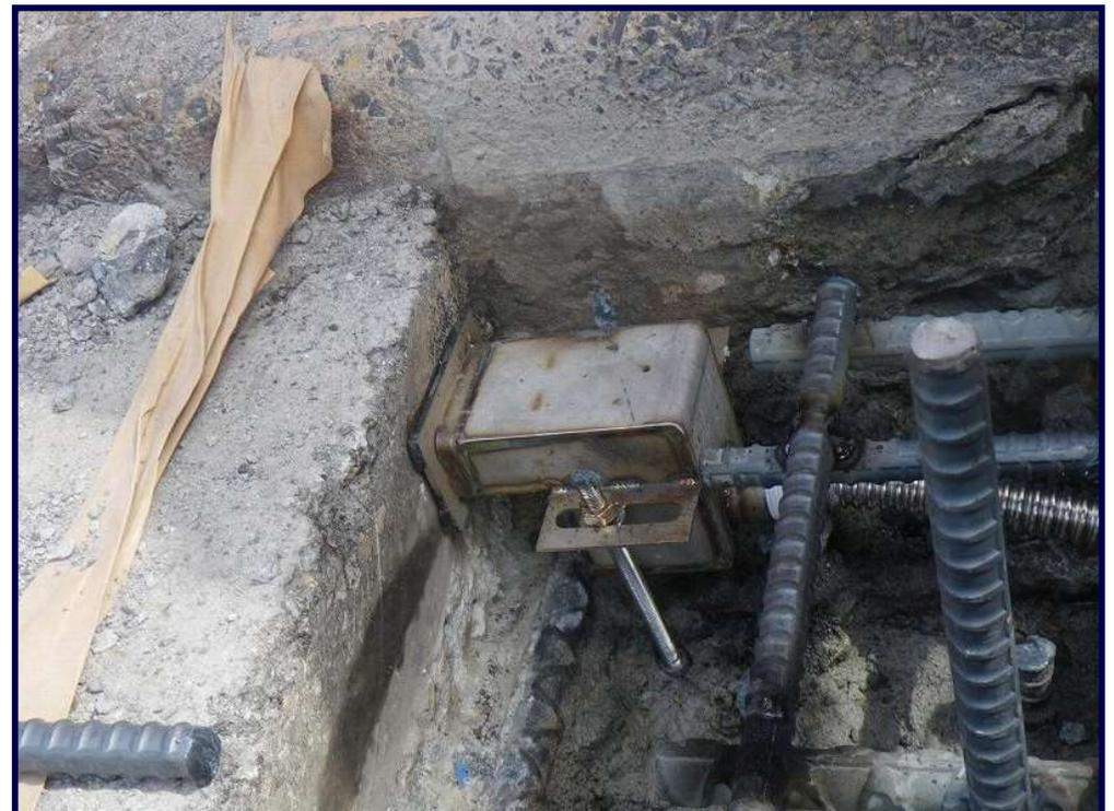
寸切りボルトの余長が施工の妨げになる場合はディスクグラインダーなどを使用して切断します。
