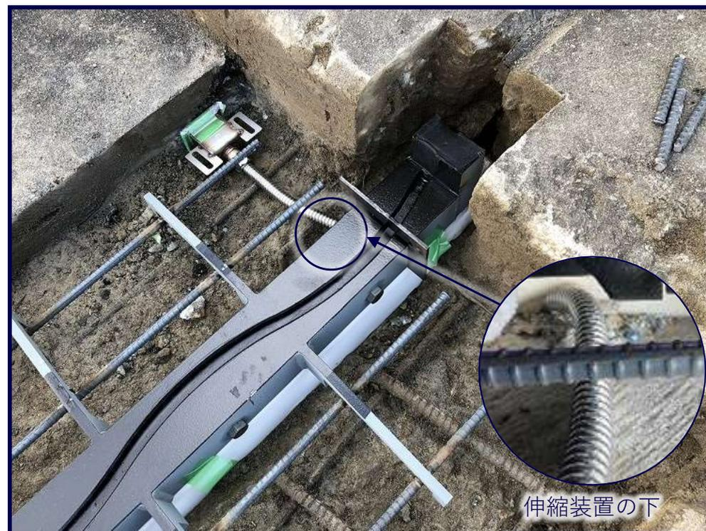
伸縮装置の設置完了後、伸縮装置とジョイントドレーンとの間で干渉がないかを確認します。
