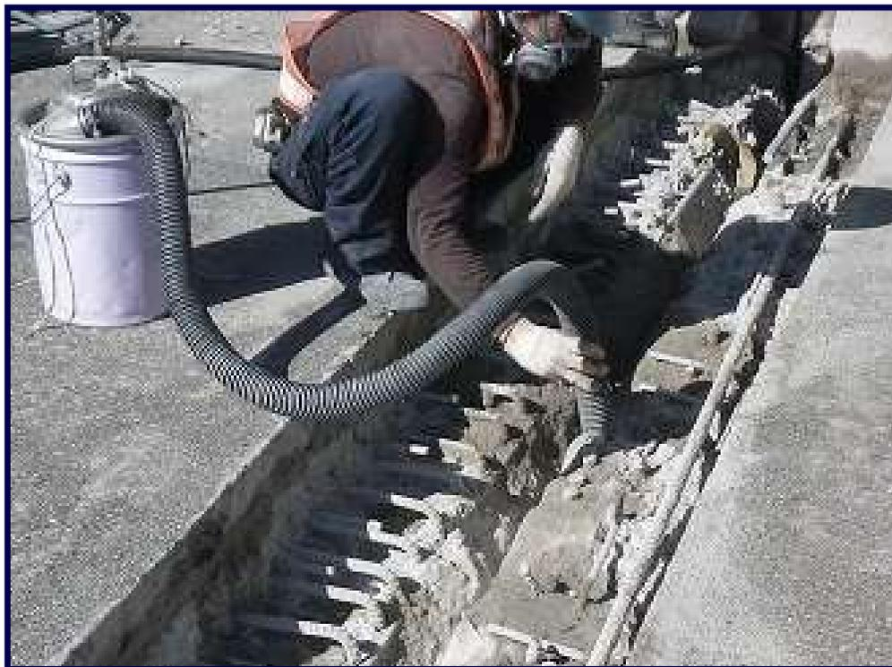
床版の脆弱部分は人力にて撤去します。ジョイントドレーンの設置位置を確認し、設置面となる床版側面が平滑になるよう入念に仕上げます。
