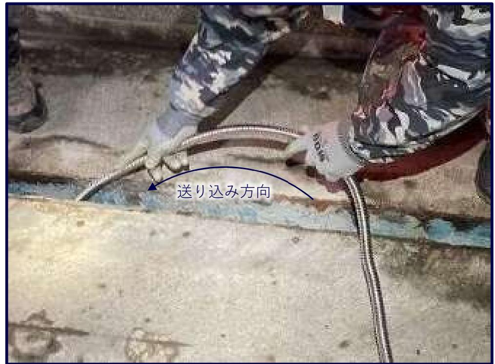
伸縮装置を設置する前に遊間からフレキシブル管の先に取り付けた排水ゴムホースを配管します。
