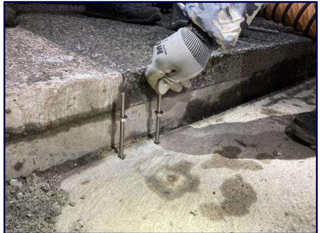
寸切りボルトを拡張式アンカーに固定していきます。台直しは必要に応じて行ってください。
