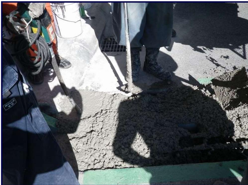
伸縮装置設置箇所にコンクリートを打設します。
