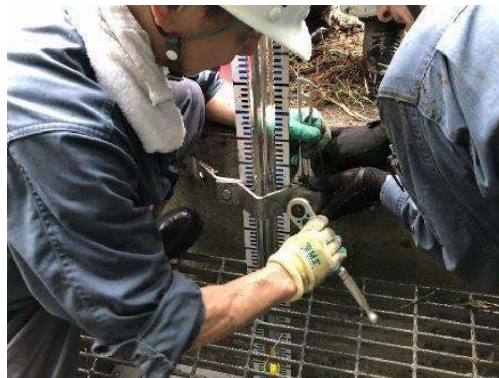
【量水標補強材取付け】
