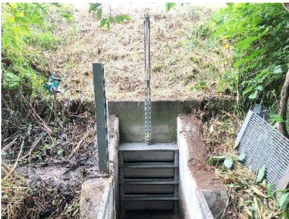
【設置完了後の全景】
