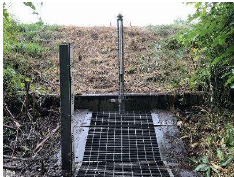
【施工終了後の全景】
