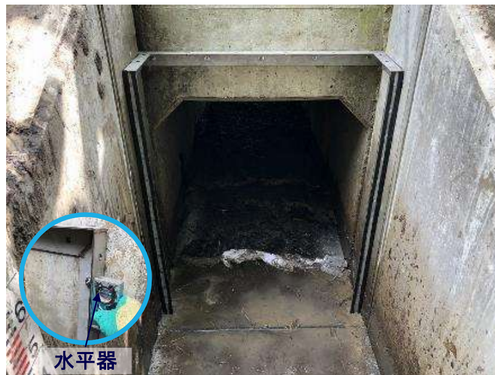
【外枠設置完了】
