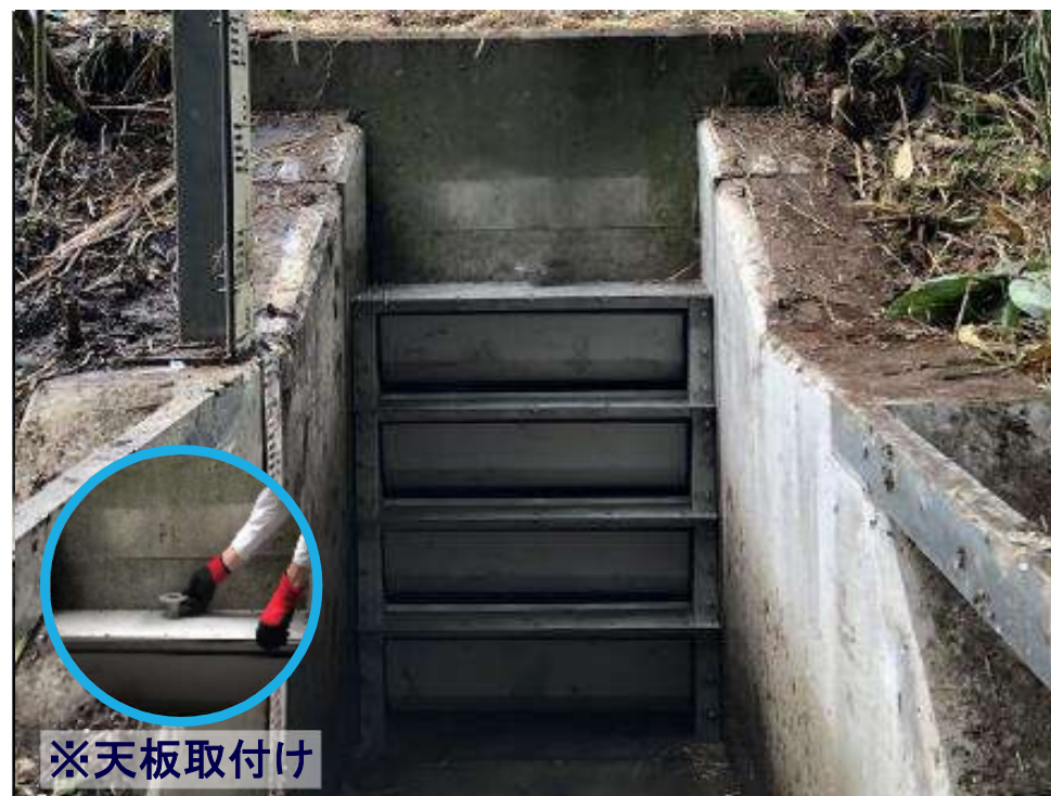
【本体設置完了】
