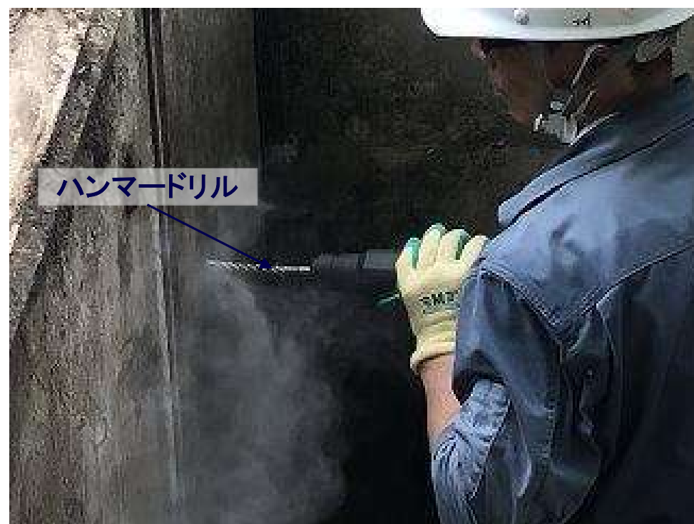
【ハンマードリルによる削孔】
