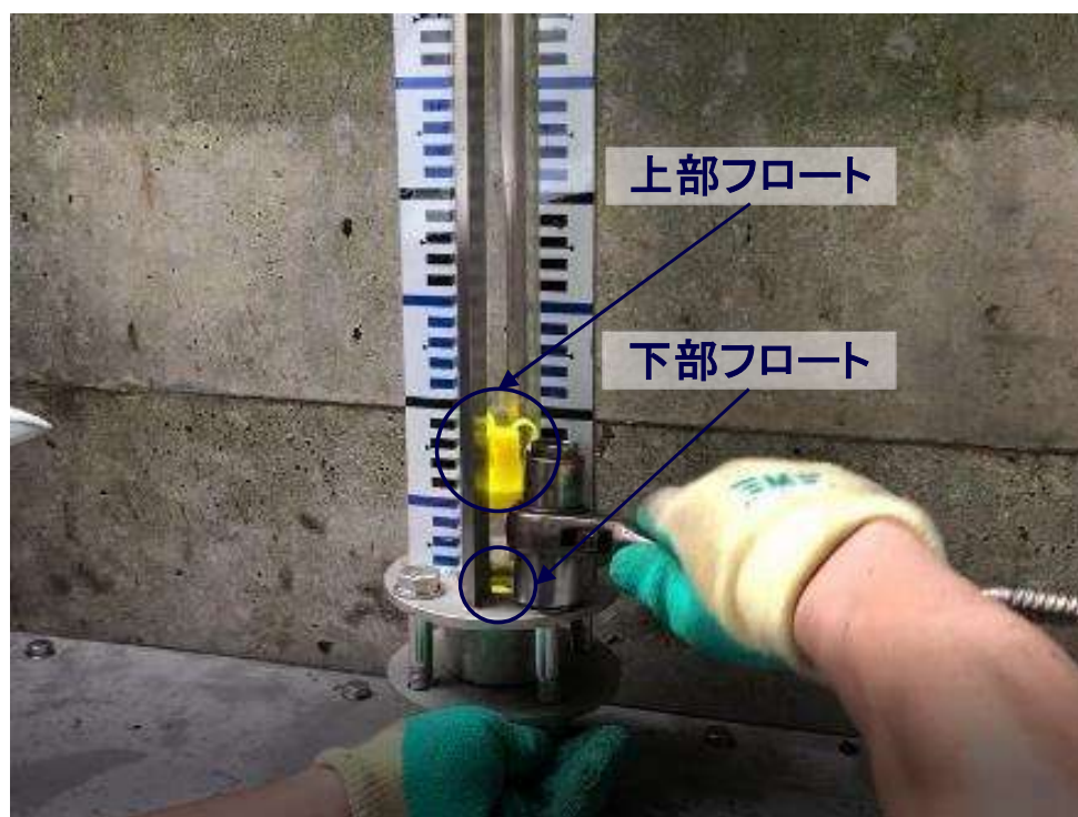
【量水標取付け】
