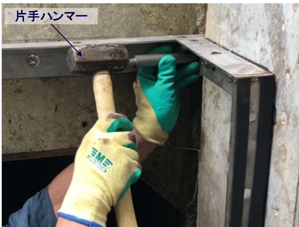
【拡張式アンカーの打込み】
